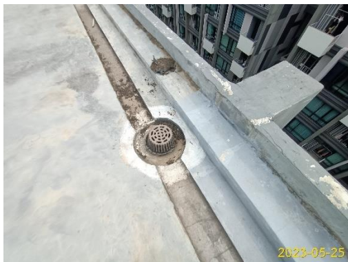
ตะแกรงครอบท่อระบายน้ำ
