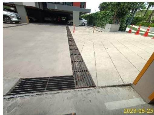
ตะแกรงครอบท่อระบายน้ำ
