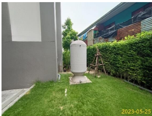
ระบบกำจัด Aerosol/ระบบกำจัดมีเทน
