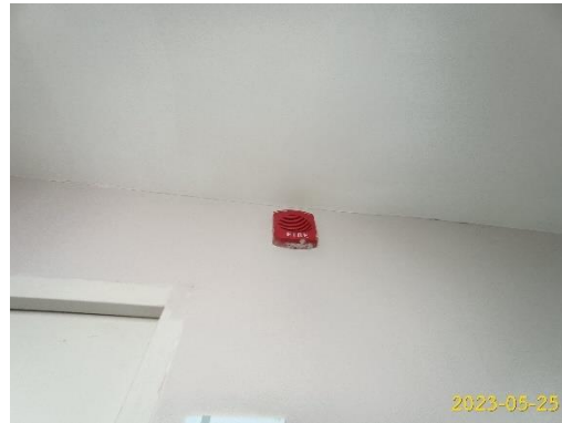
อุปกรณ์ส่งสัญญาณเตือนแจ้งเหตุเพลิงไหม้
